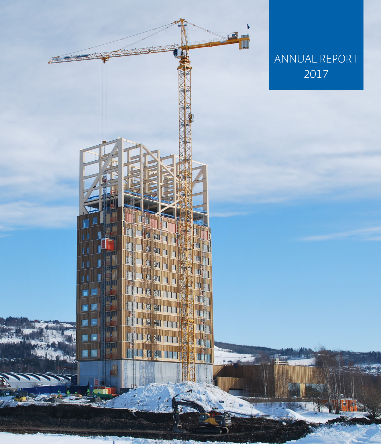
Mjøstårnet, Brumunddal. Photo: Moelven
